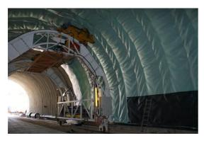
Гидроизоляционная мембрана **FLAGON BSL** на лицевой поверхности мембраны имеет тонкий цветной слой, который позволяет быстро визуально обнаружить любые повреждения, возникшие при монтаже. Этот слой называется "сигнал-слой".
