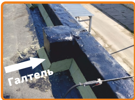
Галтель (наклонный бортик)
