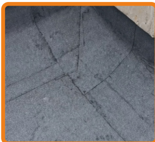
Наружный угол нижний слой Наружный угол верхний слой
